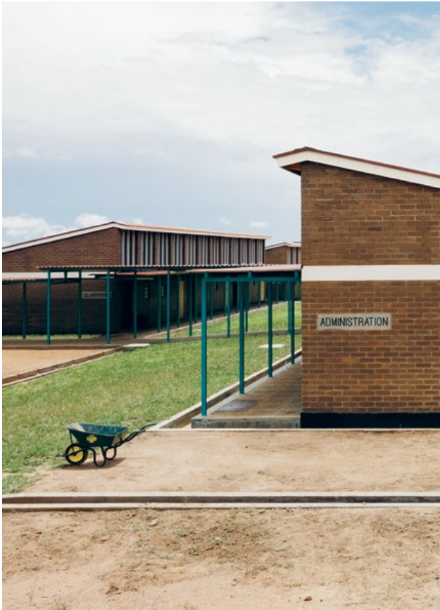
L'Institut de formation des maîtres de Lilongwe a été construit, en 2016, en briques DURABRIC.
