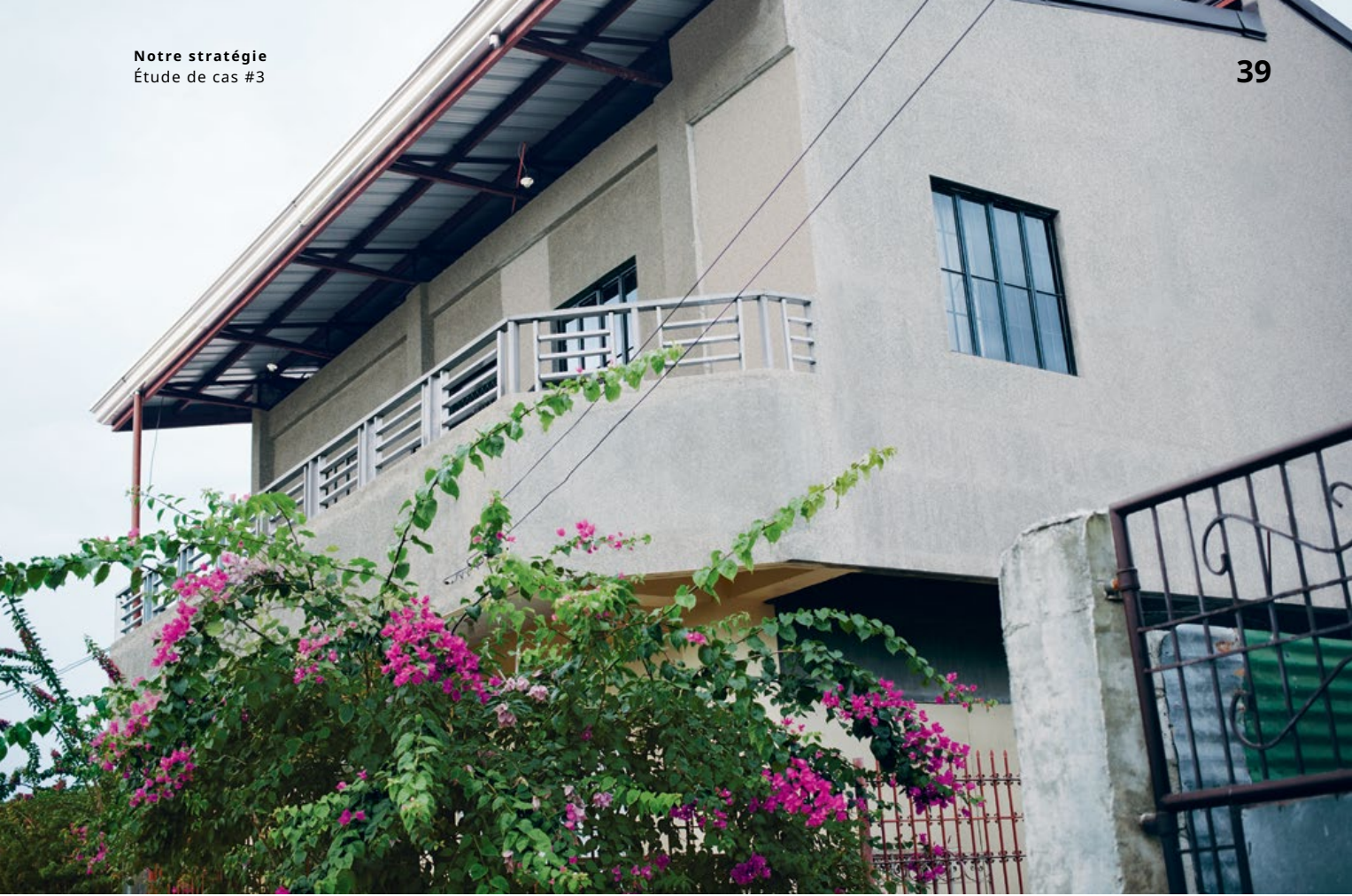
La maison de Nida Santa Romana en est au stade des finitions.
